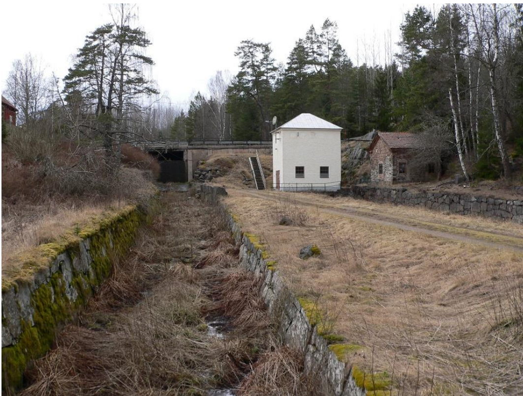
Figur 10: Forsaströms Övre vattenkraftverk på samma plats som figur 9. Foto: Göran Börkén, 2016.
